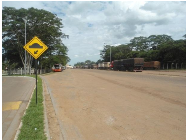
Estacionamento de caminhões
